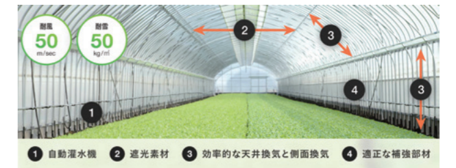
今までまったく農業との関わりがなかった企業のゼロベースからの農業への新規参入向けハウスソリューションにおけるビニールハウスの設計例。自動灌水等により収量量倍増を見込む
