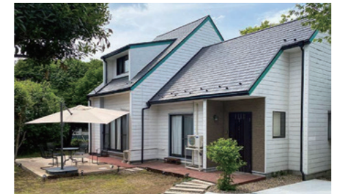
首都圏郊外の戸建て住宅をサブスク居住施設として再生
